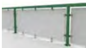
H TABLERO DE HPL DE ESPESOR 10 mm HPL PANEL 10mm THICK. PANNEAU EN HPL 10mm D'ÉPAISSEUR.
